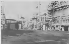
E areanan di Hydrogen Plant a wordo haci pareuw y asfalta.
